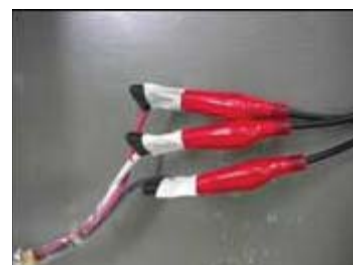
Рис. 2-4 Зажимы, изолированные изоляционной лентой
