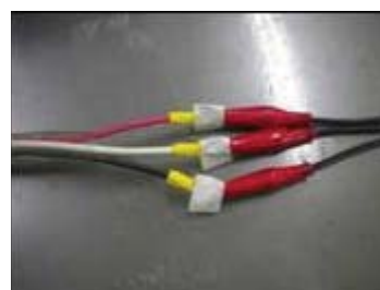
Рис. 2-7 Зажимы, изолированные изоляционной лентой
